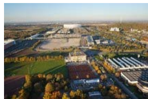
Richtfest des DAV Kletter- und Boulderzentrums in Freimann
